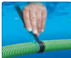
Reparation under vatten
