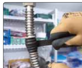
Reparation av tryckluftsslangar
