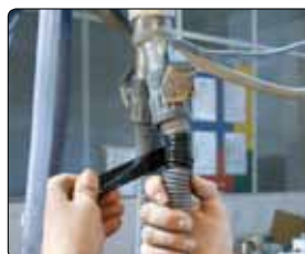
Reparation av flexibla slangar
