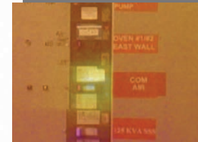
Przenikanie na poziomie 50 %, obraz przycięty w celu uwidocznienia szczegółów
