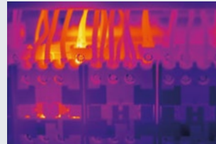
Svolgere la manutenzione degli impianti: rilevare temperature troppo alte dei fusibili o dei componenti elettrici prima che sia troppo tardi.
